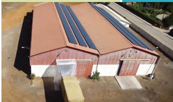
SISTEMA FV SOBRE TECHO INCLINADO
