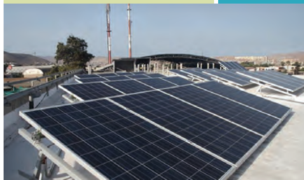
SISTEMA FV INCLINADO SOBRE TECHO PLANO
