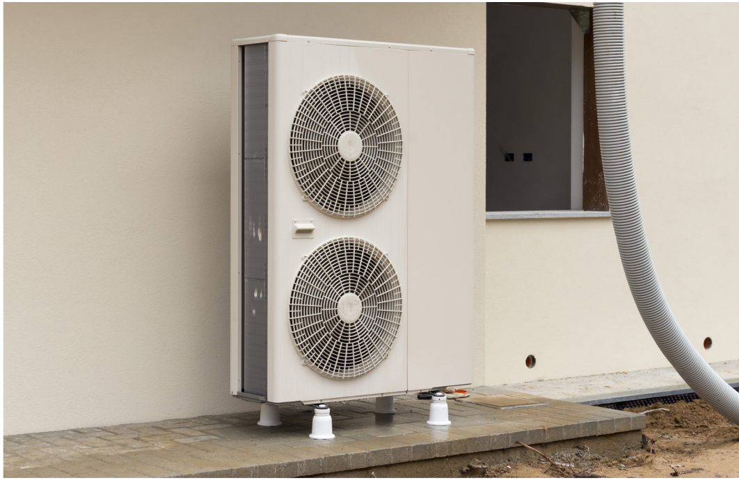
Figura 6: Bombas de calor aerotérmicas reversibles para clima y ACS. Fuente [4]: Shutterstock image by caifas.
