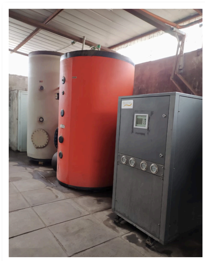
Figura 16: Bomba de Calor, Unifrutti, Chile. Fuente [9]: Unifrutti, 2012.
